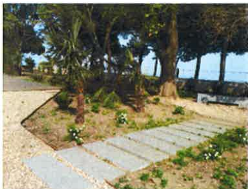
Obra a decorrer
