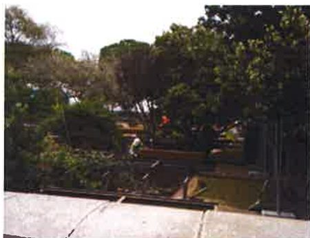
Obra a decorrer
